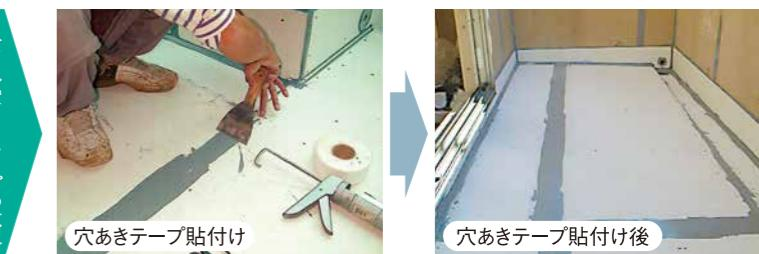
穴あきテープの貼付けは、突き合わせ部に変成シリコーンで平滑に押さえます。突き合わせ部は、穴あきテープにて絶縁になるので、下地の動きに影響されません。
