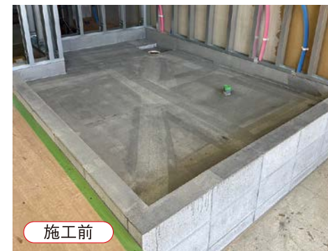
浴室（下地防水）
